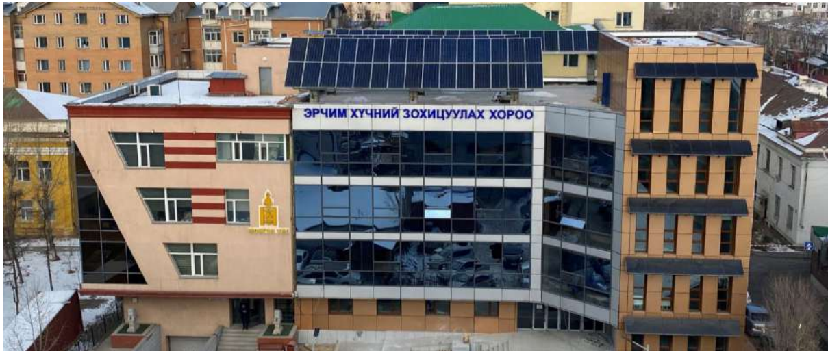
Зураг 44 Байгууллагын дээвэр дээр суурилагдсан нарны цахилгаан үүсгүүр
